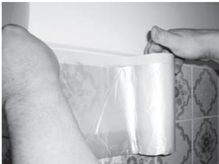
Obr. 4 Složená fólie s papírovou lepicí páskou
