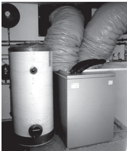
Obr. 4 Tepelné čerpadlo vzduch/voda – vnitřní provedení
