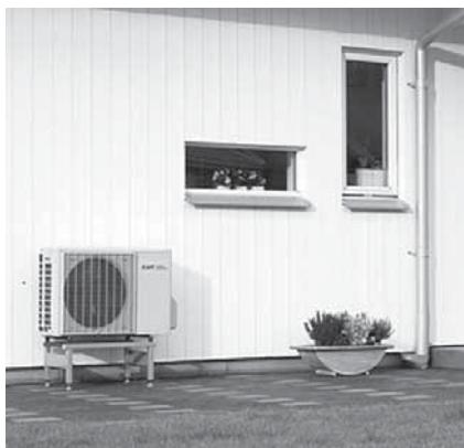
Obr. 5 Tepelné čerpadlo vzduch/vzduch – venkovní jednotka
