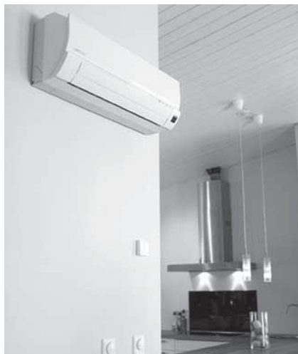
Obr. 6 Tepelné čerpadlo vzduch/vzduch – vnitřní jednotka
