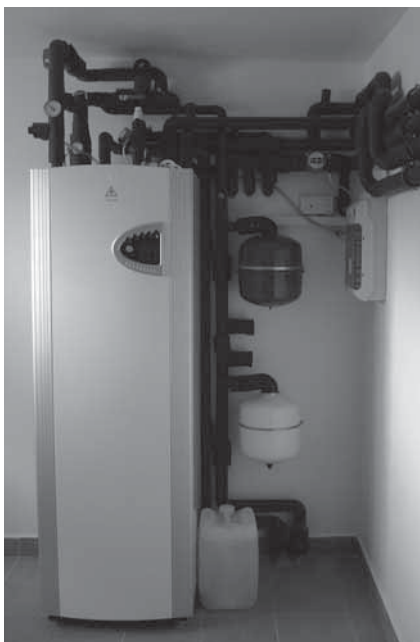
Obr. 2 Tepelné čerpadlo země/voda
