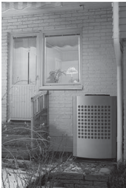
Obr. 3 Tepelné čerpadlo vzduch/voda – venkovní jednotka
