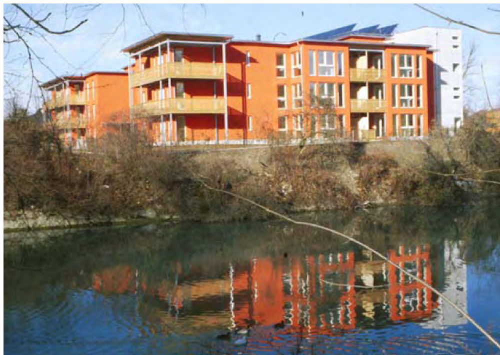
Obr. 1.1 Bytový dům v Halleinu (Rakousko) architekta Othmara Essla, realizace v roce 2000. Jeden ze čtrnácti projektů pasivních domů podpořených evropským projektem CEPHEUS [4]
