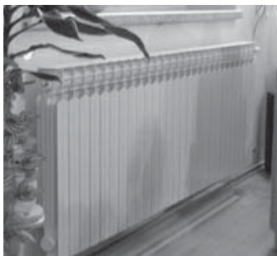
Obr. 9 Hliníkový radiátor výšky 578 mm
