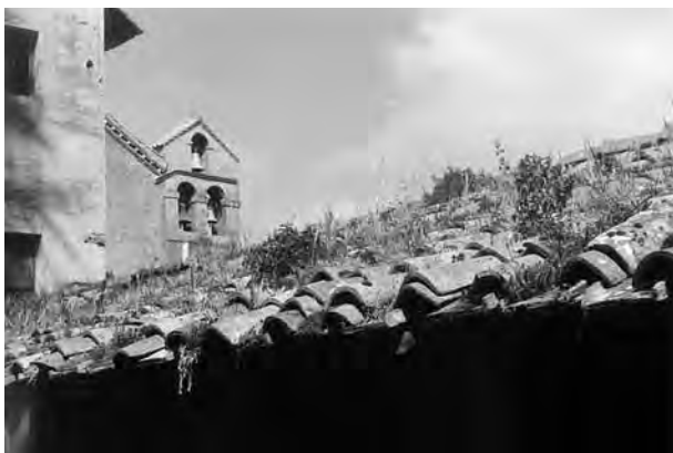
Obr. 2.3 Prejzová krytina (Abbazia delle Tre Fontane, Řím)
