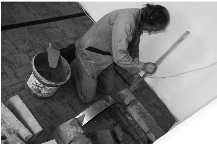
Obr. 12 Realizace v praxi – stále kontrolovat roviny
