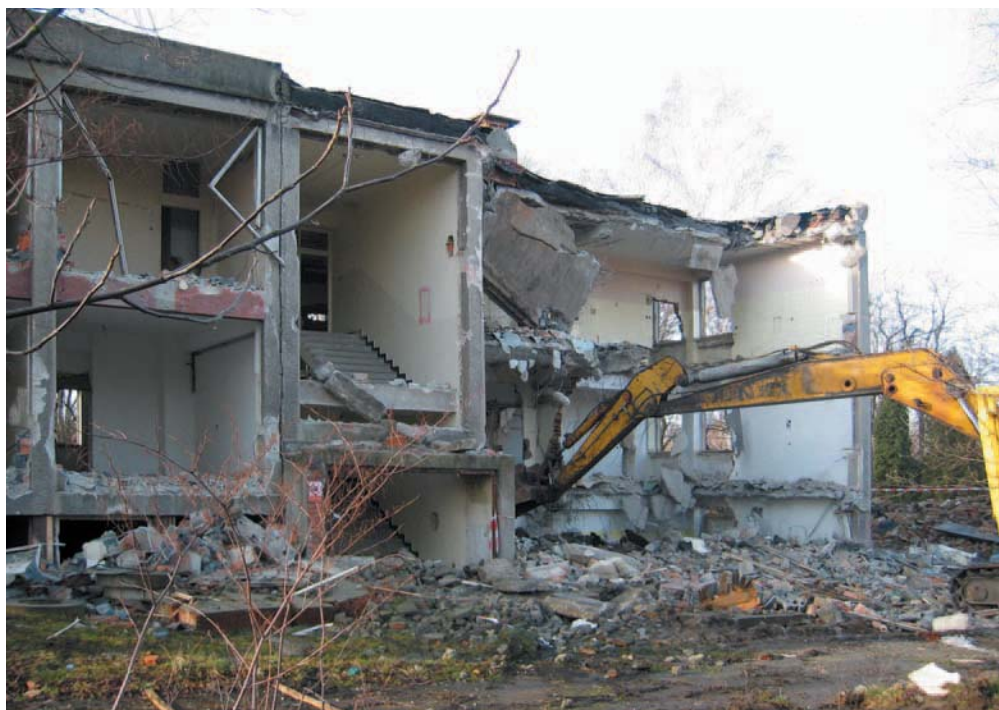
Obrázek 3.1 Ukázka demolice celého objektu s použitím těžké mechanizace
