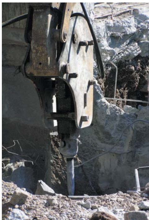
Obrázek 3.2 Bourání pneumatickým kladivem
