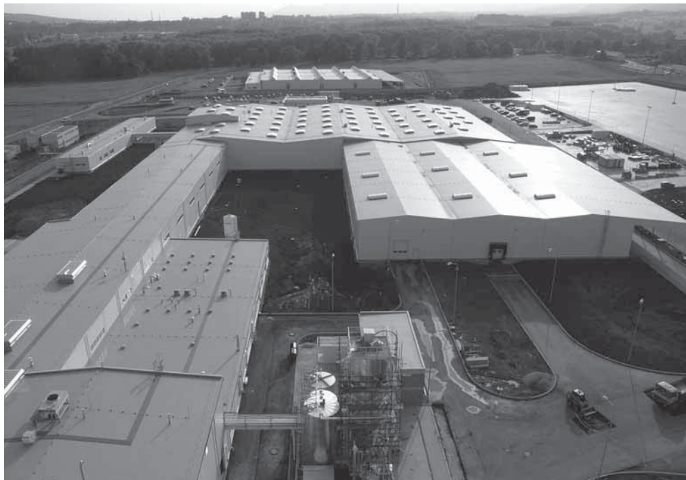
Obr. 1.3 Vodotěsná izolace z hydroizolační fólie RHENOFOL na areálu firmy KNAUF (foto FDT)
