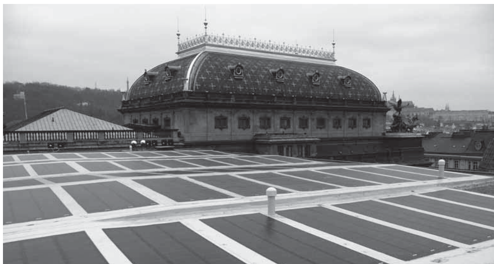
Obr. 1.5 Hydroizolační fólie EVALON – Solar s integrovanými fotovoltaickými články – střecha Provozní budovy Národního divadla v Praze (foto FDT)
