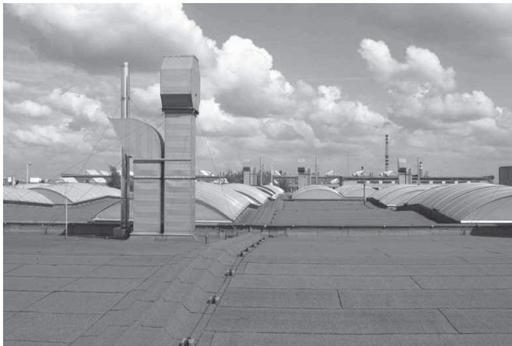
Obr. 1.4 Vodotěsná izolace z asfaltových pásů ICOPAL – hala DP Praha v areálu Praha 10-Hostivař
