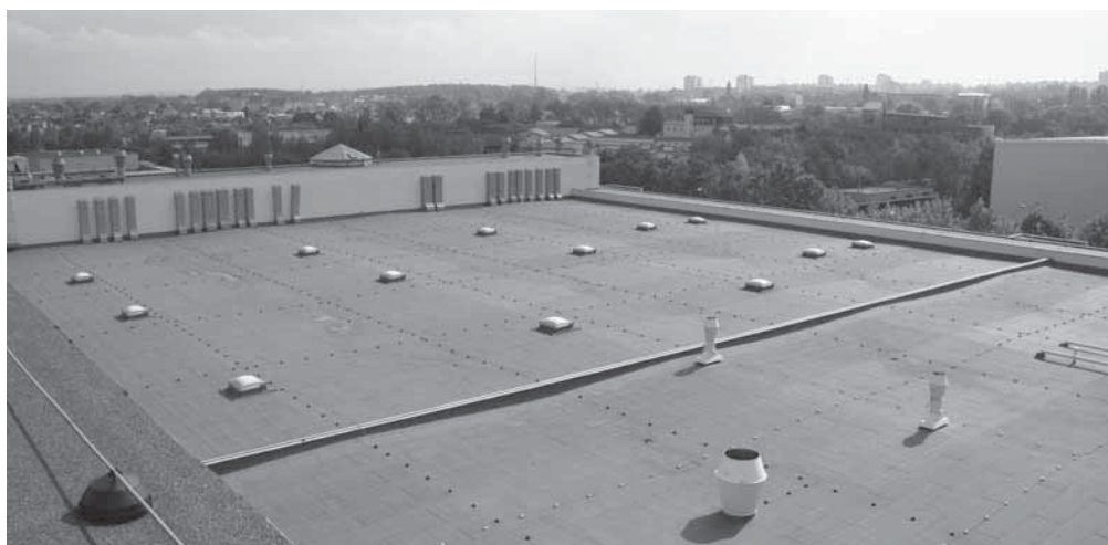
Obr. 1.1 Vodotěsná izolace z asfaltových pásů VEDAG – hala firmy Zentiva v Praze 10 (foto VEDAG – ČR)
