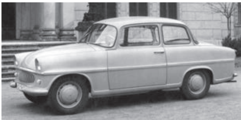
Prototyp Š 978 měl samonosnou karoserii konvenčních tvarů
