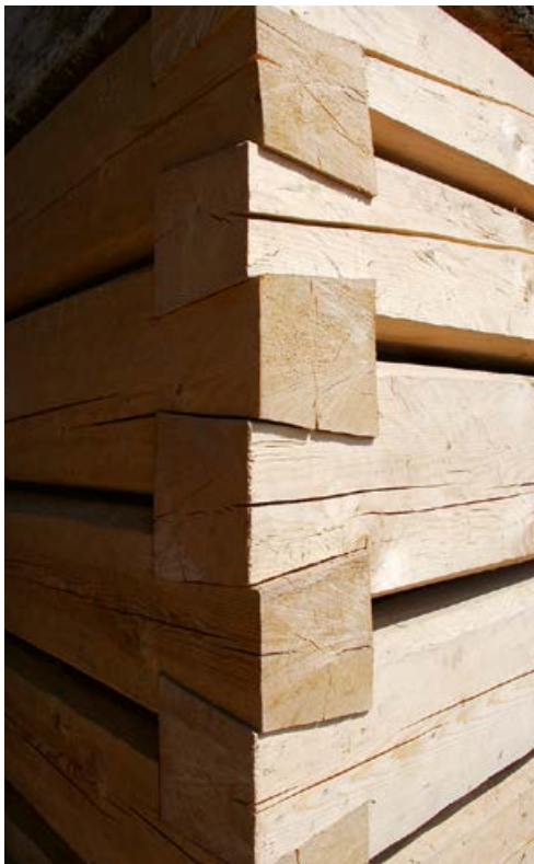
Obr. 10 Na řemeslnou dovednost dávných tesařů se snaží navázat i řada jejich dnešních pokračovatelů. Na snímku precizně a technicky správně provedená rohová rybinová vazba stěnových trámů.
