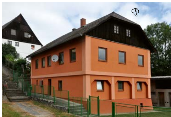
Obr. 6 I takto může dopadnout „obnova“ roubené stavby. Původně typický patrový podstávkový dům postupnými adaptacemi zcela ztratil tradiční malebný ráz; autentický již zůstává jen štít (Českolipsko).
