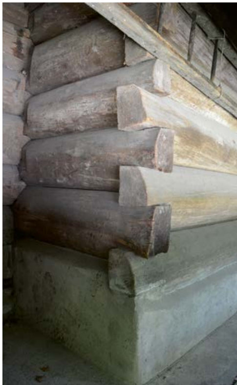
Obr. 11 Rohové spoje půlkulatých srubových trámů s vnitřním zámekem na nároží lodi kostela v Gutech u Třince z 16. století, vypáleného v létě 2017.
