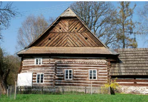
Obr. 8 Stěnové konstrukce z nehraněných klád i otesaných trámů daly vzniknout nejedné památce lidového stavitelství. Na snímku jeden z bezesporu nejkrásnějších domů na Vysočině (Telecí, Poličsko).
