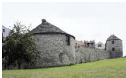
Bašty městského opevnění (Louny)
